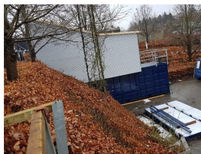
Ny bygning til flamingo-komprimator
